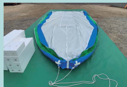
フロート内部に芯材を入れていきます
